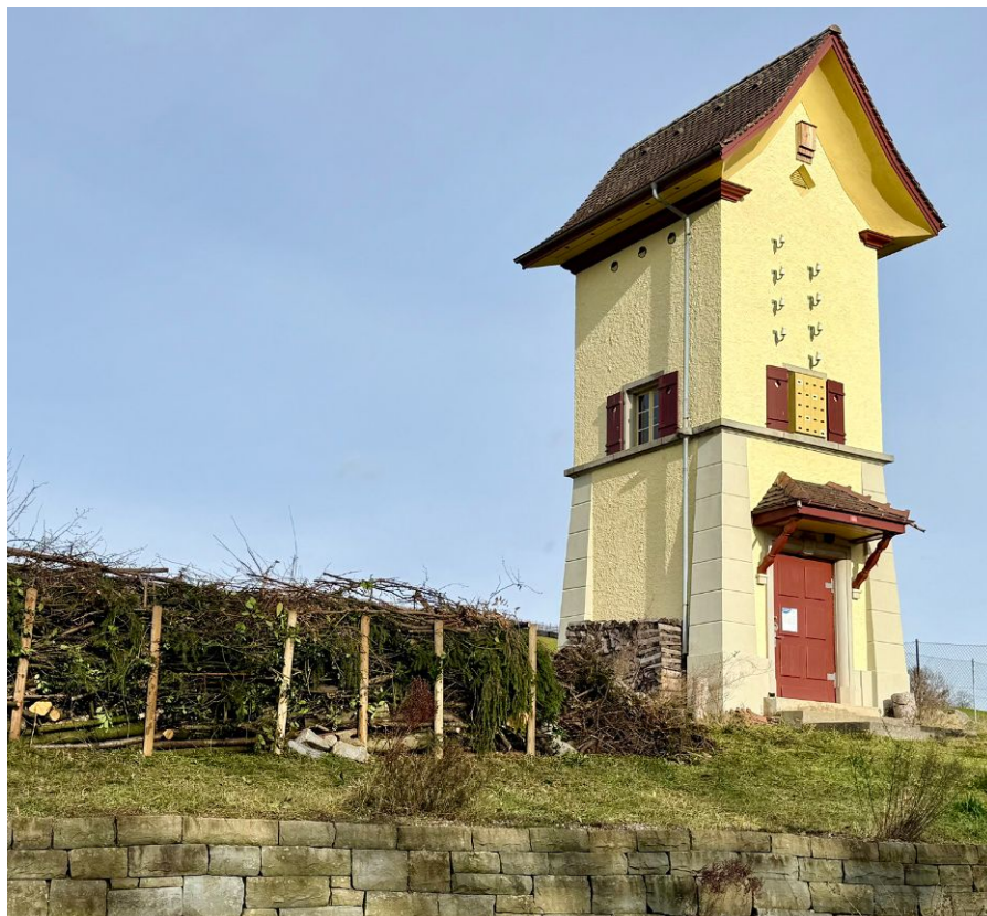
Die historische Transformatorstation von 1925 wurde zum Artenschutzurm umgebaut und bietet gemeinsam mit den umliegenden Asthaufen heute Nist- und Lebensräume für Mauersegler, weitere Vögel, Fledermäuse, Igel, Wiesel, Eidechsen und Wildbienen.
